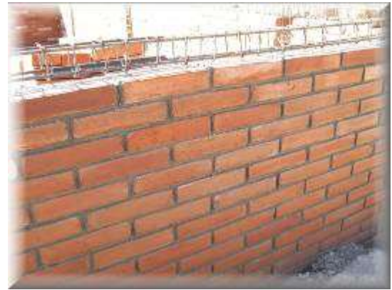
Figura N° 28 Construcción con sistema de Mampostería confinada y paredes de Cerramientos con Ladrillo cuarterón
