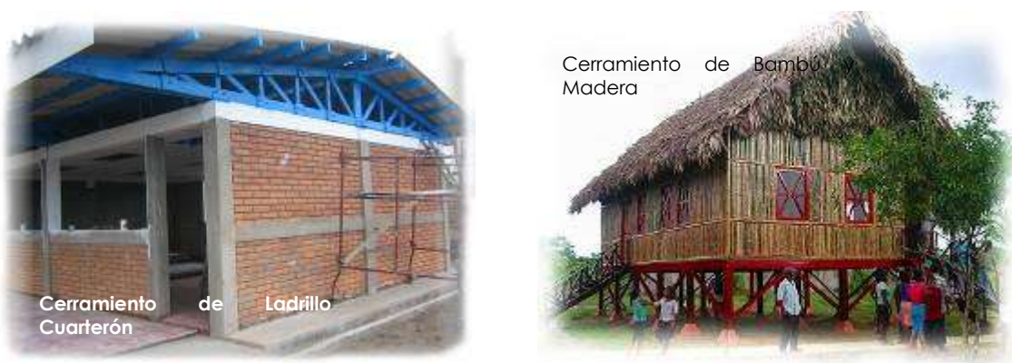
Figura N° 31 Ejemplos de paredes de cerramientos de Establecimientos Escolares
