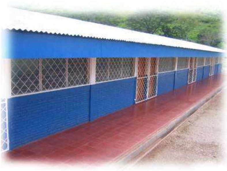
Figura N° 32 Pintura en Establecimientos Escolares
