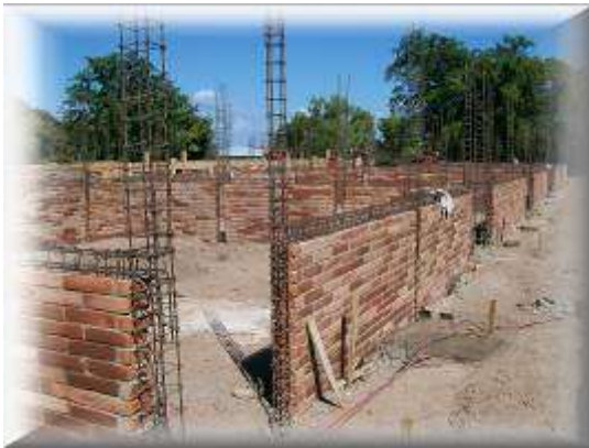
Figura N° 28 Construcción con sistema de Mampostería confinada y paredes de Cerramientos con Ladrillo cuarterón
