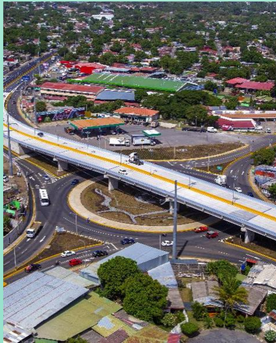
Puente Desnivel Rubenia (Barricada de la Esperanza)
